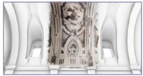
Fig. 7 Forastamento della volta della terza cappella, lato destro.
