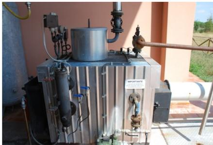
Nella parte esterna del caseificio è presente una caldaia per la produzione di vapore; i tubi di mandata del vapore costituiscono un pericolo per il personale non adeguatamente addestrato per le temperature che possono determinare scottature. Le zone in cui è presente il pericolo sono identificate dal cartello di **attenzione alle temperature pericolose**.
