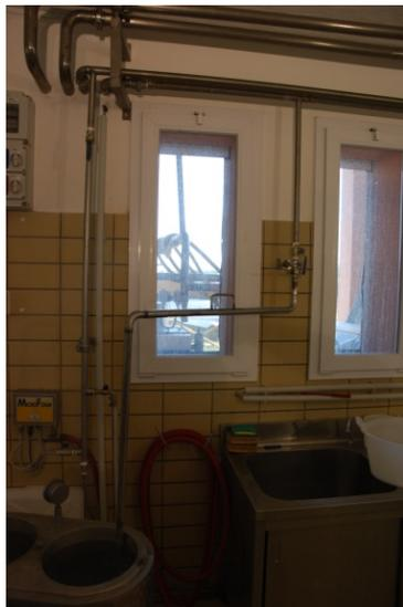
Le tubazioni in acciaio poste all'interno del caseificio trasportano il vapore necessario alle lavorazioni e costituiscono un pericolo per il personale non adeguatamente addestrato per le temperature che possono determinare scottature. Le zone in cui è presente il pericolo sono identificate dal cartello di **attenzione alle temperature pericolose**
